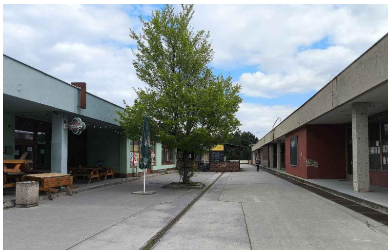
Obrázek 91: Zatímco v dolním patře nyní funguje prodejna Billy, to horní zeje prázdnotou. Opravu zbytku brněnské Kotlanky v Líšni nyní brzdí spor o nutnost stavebního povolení. Zdroj: Deník/Sára Němcová
