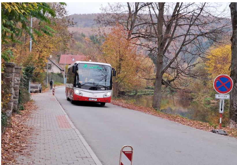
Obrázek 134: V sobotu začala dvouletá uzavírka Fryčajovy ulice v brněnských Obřanech. Kvůli rekonstrukci vodovodu a kanalizace. Minibusy jezdí úzkými ulicemi, auta musí objížděnou přes Ochoz. Zdroj: Deník/Michal Hrabal
