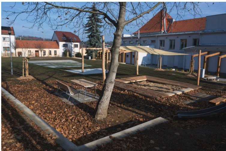
Obrázek 127: Dělnák po rekonstrukci – celkový pohled.
