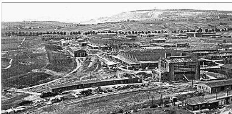
Obrázek 141: Výstavba továrny v roce 1942.
