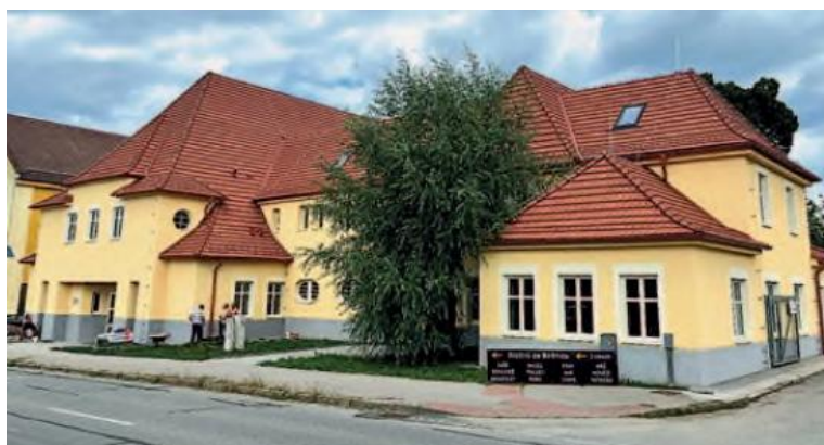
Obrázek 22: Opravená budova Orlovny.
