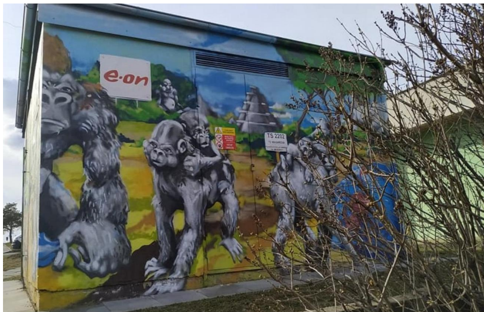
Obrázek 88: Trafostanice v brněnské Líšni. 227
