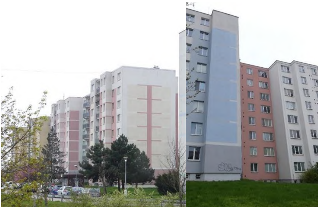
Lok. 2. Jírova 23 západní stěna bez oken (nalevo). Případně předsazené stěny bez oken na Jírova 1, 5, 9 a 13 (napravo). Podmínky pro hnízdění poštolek i rorýsů jsou zde vhodné.
