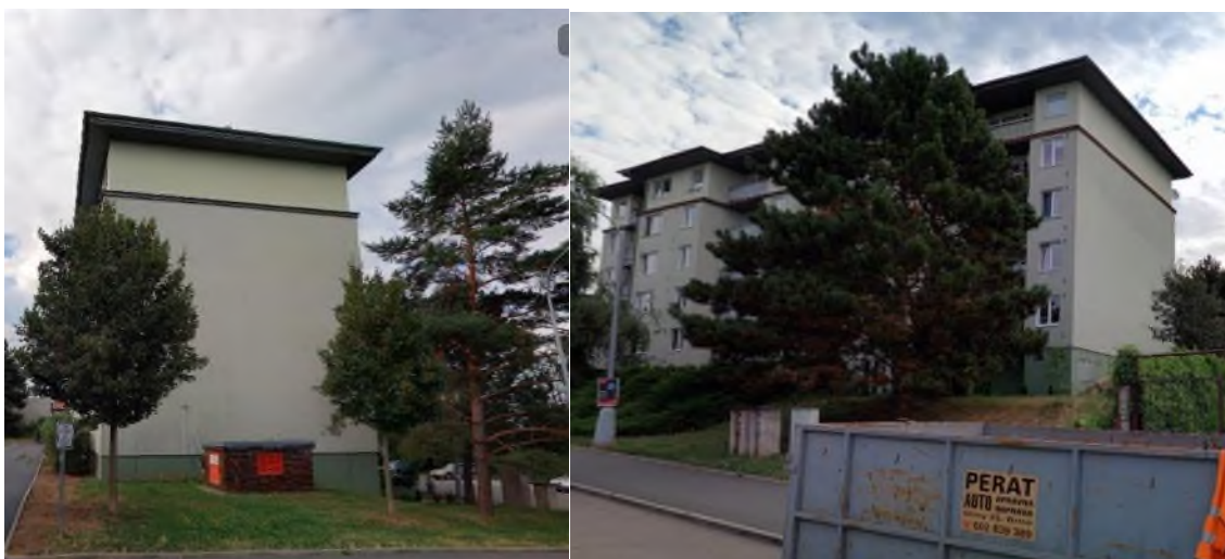
Lok. 11. Kubíkova 2 (severní strana) a Kubíkova 4 (jižní strana). Tady by bylo možné umístit budky pro rorýse i na jižní straně, protože střecha je hodně přetažená a mohla by budky v nejteplejší části dne stínit. Místo vhodné i pro budky pro poštolku.
