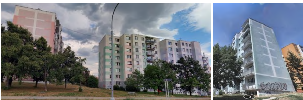
Lok. 8. Synkova 2 západní strana a Synkova 5 severní strana, případně vyčnívající zeď úplně vpravo (západní expozice).
