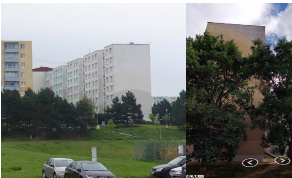
Lok. 4. Hochmanova 21 Z strana (vlevo) stěna bez oken, vhodná pro budky rorýse i poštolky, bezpečné před predátory a bez kontaktu s lidmi. Hochmanova 2 S strana (vpravo) vhodné místo jen pro budku pro poštolky.
